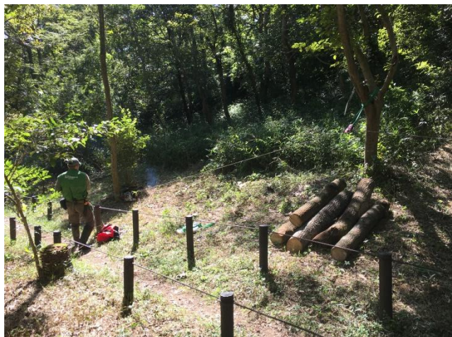
斜面上部に電動ワイヤウインチを設置する。ポータブル発電機を合わせて設置
