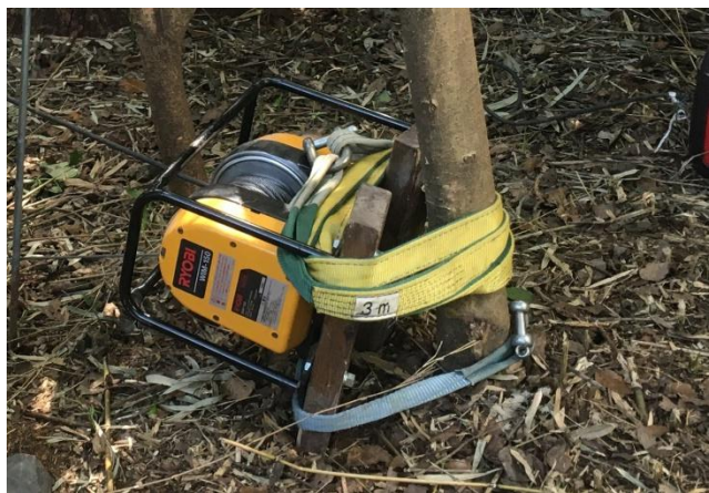
斜面上部に電動ワイヤウインチを設置する。ポータブル発電機を合わせて設置
