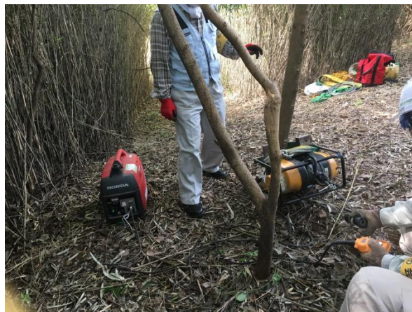
斜面上部に電動ワイヤウインチを設置する。ポータブル発電機を合わせて設置
