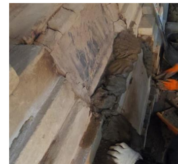
窯締め(焚き口、煙突を塞ぐ)作業 11月15日16:10
