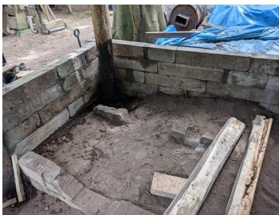
枠組の木材が腐食している
