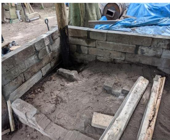
枠組の木材が腐食している
